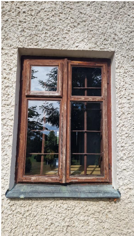
Fot. Kościół w Obszy, okno skrzynkowe do wymiany, stan zachowania na 2024 r.
