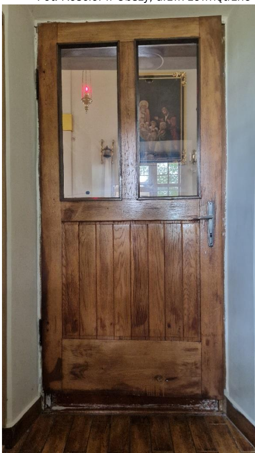
Fot. Kościół w Obszy, drzwi do zakrystii do wymiany, stan zachowania na 2024 r.
